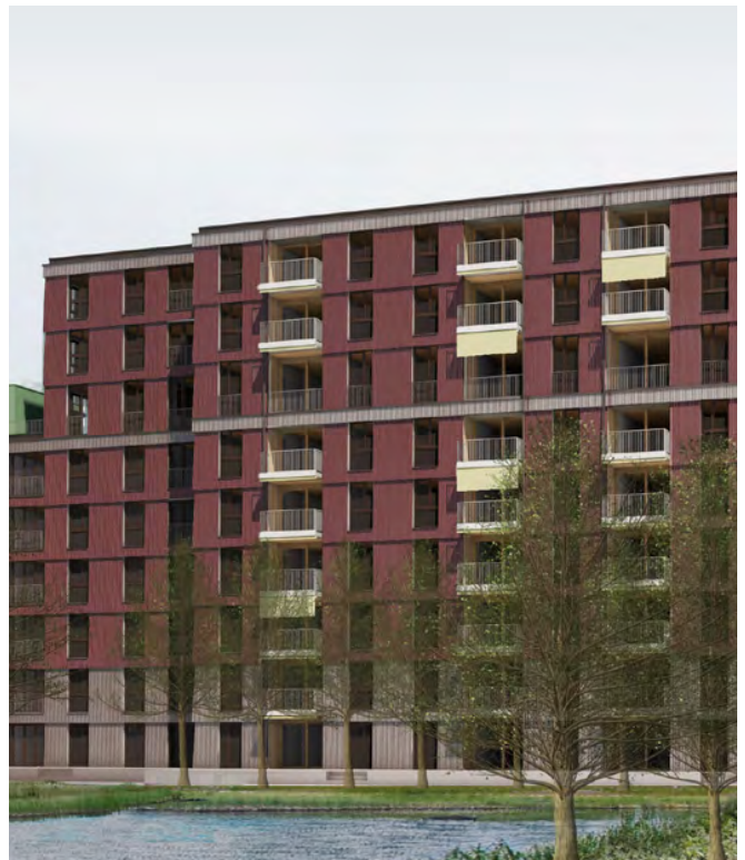
Zentrale Pratteln Fassade West mit Gliederung
