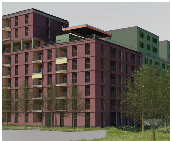
Zentrale Pratteln Ecke Ost - Nordseite
