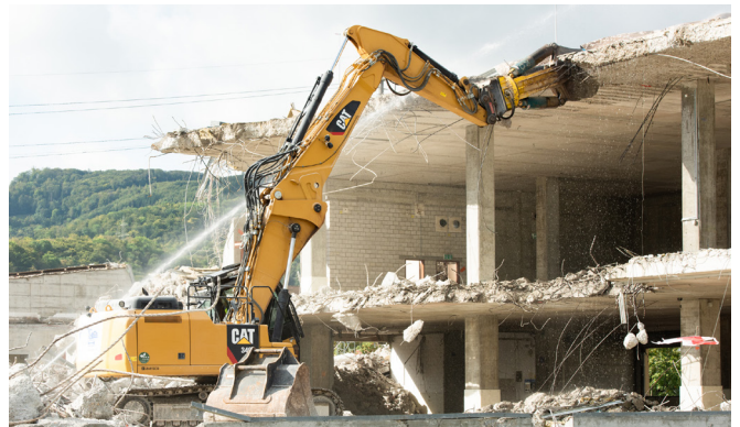
Fotos des Baufortschrittes (Abbrucharbeiten)
