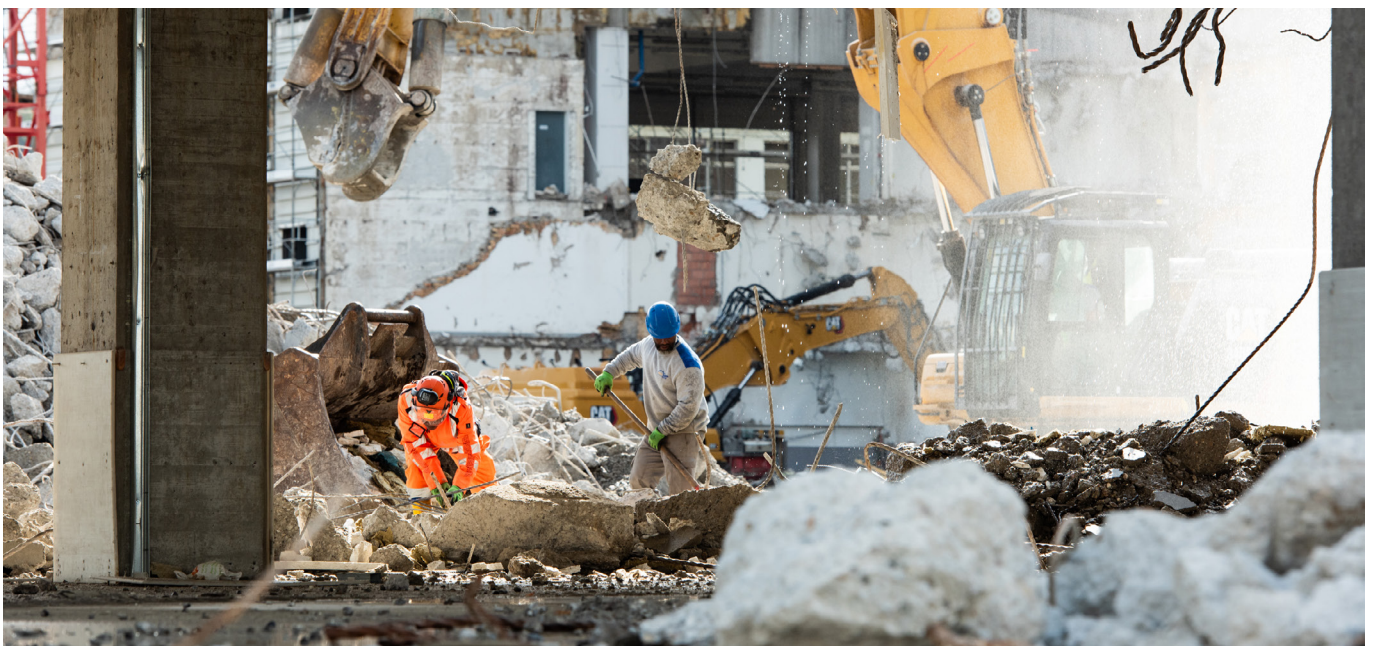
Zentrale Pratteln, Fotos des Baufortschrittes (Abbrucharbeiten)
